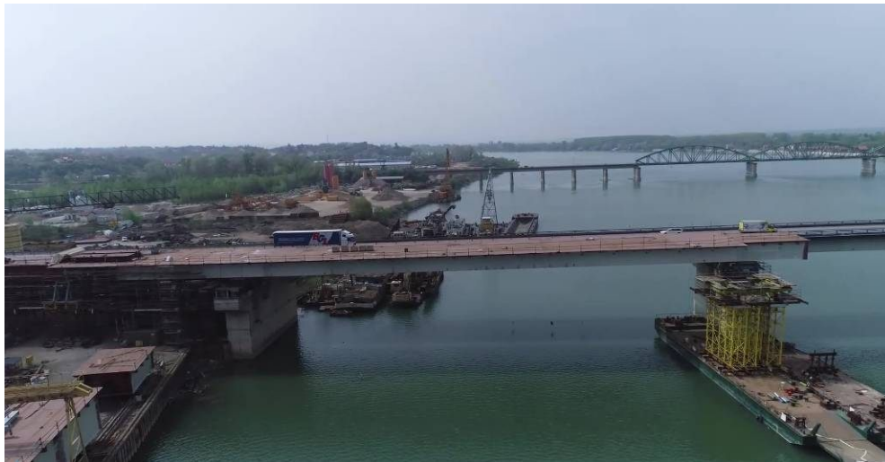
Slika 4. Druga faza podužnog prevlačenja segmenta S4–S6 Fig. 4. Second phase of incremental launching of segment S4 - S6
