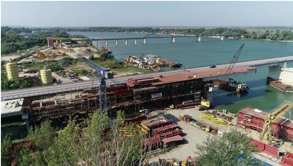
Slika 3. Prva faza podužnog prevlačenja segmenta S4–S6 Fig. 3. First phase of incremental launching of segment S4 - S6
