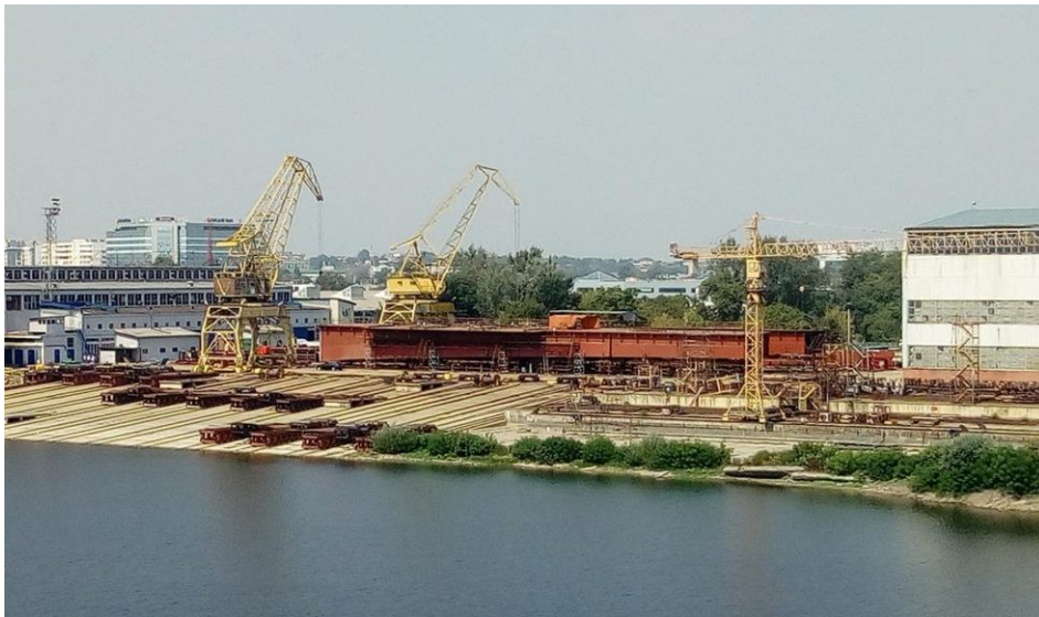
Slika 8. Predmontaža sekcija konstrukcije mosta u brodogradilištu Fig. 8. Pre-assembly of steel structure sections in the shipyard
