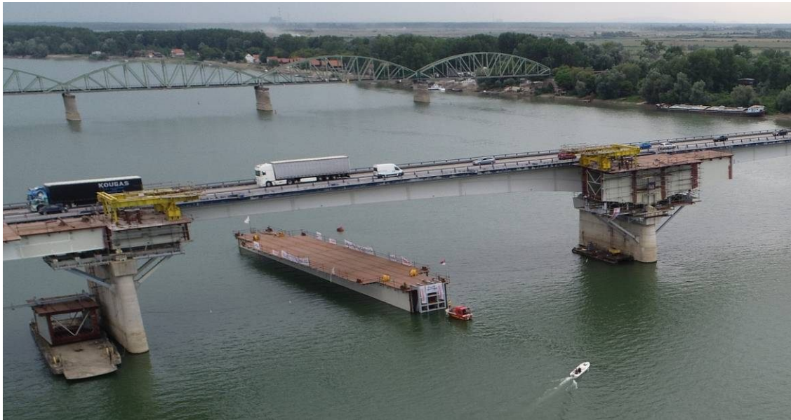
Slika 7. Stubovi S4 i S3 s montiranim pomoćnim osloncima, delovima čelične konstrukcije mosta i „Derik” kranovima Fig. 7. Piers S4 and S3 with installed temporary supports, steel structure segments and “Derrick” cranes
