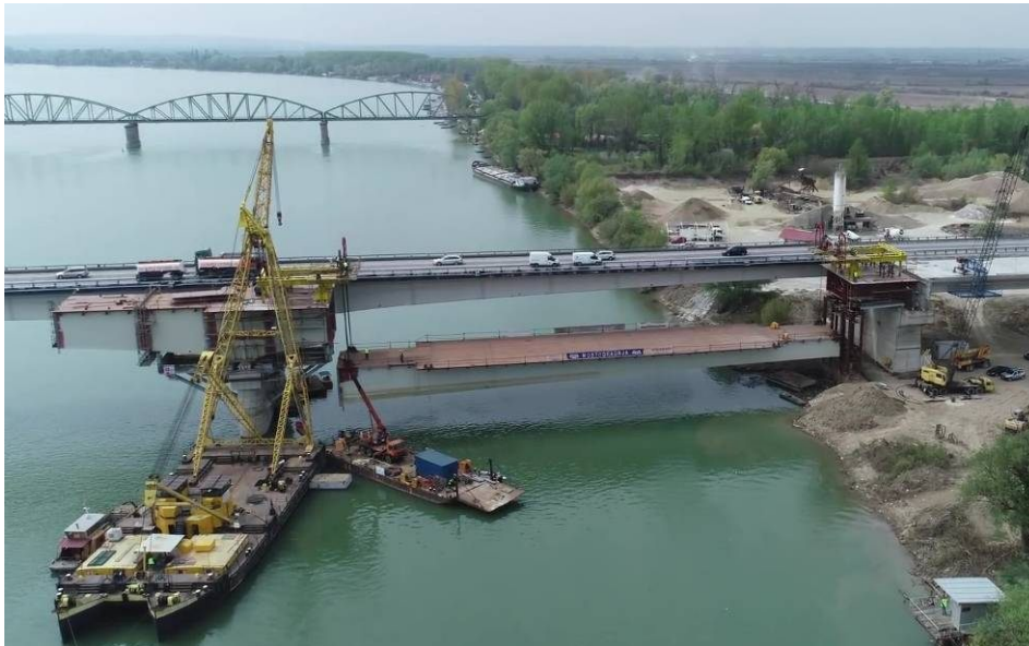
Slika 10. Podizanje segmenta S1–S2
