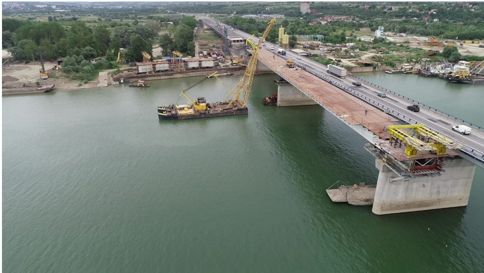
Slika 5. Segment S4 - S6 nakon završetka podužnog prevlačenja Fig. 5. Segment S4 - S6 after completed incremental launching
