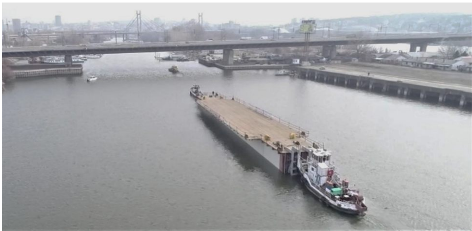
Slika 9. Rečni transport sekcija konstrukcije mosta Fig. 9. River transport of structure sections
