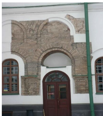
Slika 12. Prezentacija tehnike građenja i rekonstrukcija prvobitnog oblika Crkve Svete Sofije u Kijevu, prema [133] Figure 12. Presentation of construction techniques and reconstruction of the original shape of the Church of St. Sophia in Kiev, after [133]
