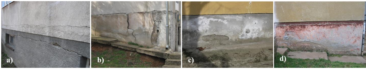
Slika 6. Oštećenja temeljnog zida: a) strukturalne pukotine, b) otpadanje obloge, c) iscvetavanje, d) karbonatizacija Figure 6. Plinth wall damages: a) structural cracks, b) wall cover falling off, c) salt crystallization, d) carbonation
