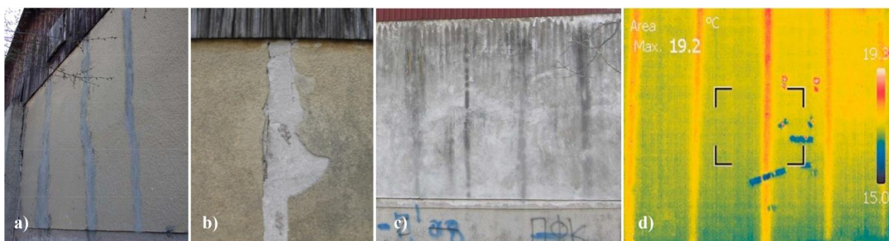
Slika 9. Oštećenja fasadnog maltera usled bubrenja drvene građe, mrlje na mestima termičkih mostova (slika: P. Petronijević), Efeka termičkog mosta na mestima čeličnih profila kod zidova lakih montažnih konstrukcija [24]
