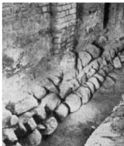
Slika 14. Primeri romaničkog temeljenja, prema [96] Figure 14. Examples of Romanesque foundations, after [96]
