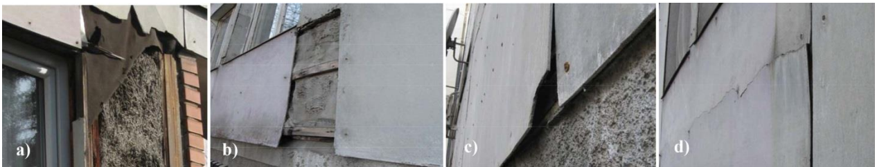
Slika 5. Karakteristična oštećenja fasadnih panela od azbesta (slika: P. Petronijević) Figure 5. Characteristic damage to the asbestos panels (photo: P. Petronijević)
