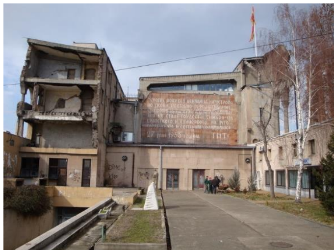
Slika 20. Kuća bondručne konstrukcije i Železnička stanica, efekti skopskog zemljotresa iz 1963. godine, prema [67] Figure 20. House of post-and-pan structure and Railway Station, effects of the Skopje earthquake from 1963, after [67]
