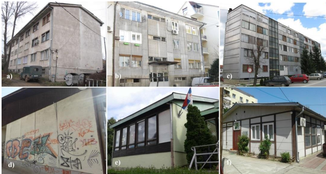
Slika 1. Tipovi fasada lakih montažnih objekata: a) malterisana fasada, b) azbestne ploče, c) limena obloga, d) paneli odIVERICE, e) drvena obloga, f) paneli od lakog betona
