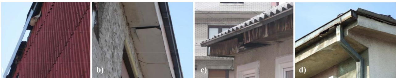
Slika 7. Oštećenja strehe (slika: P. Petronijević) Figure 7. Damage to the eaves (photo: P. Petronijević)
