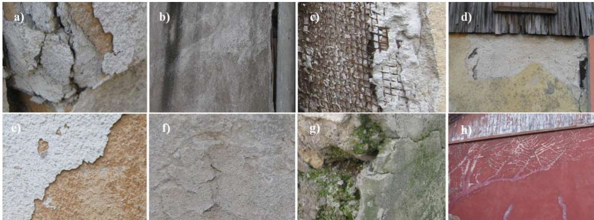
Slika 4. Karakteristična oštećenja malterisanih fasada (slika: P. Petronijević) Figure 4. Characteristic damage of plastered facades (photo: P. Petronijević)
