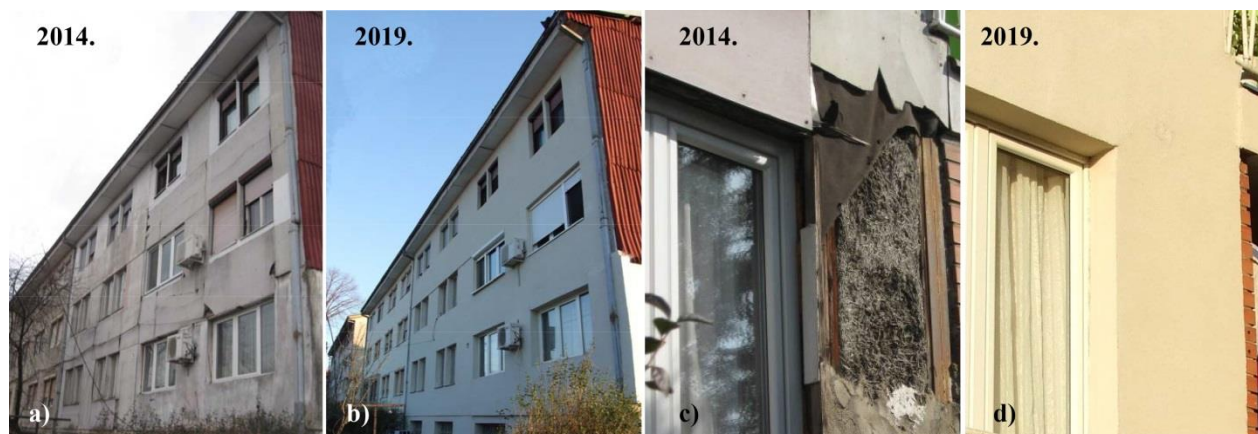
Slika 13. Intervencije na fasadama objekti Tip 1 (Apelovac, 2014-2019) Figure 13. Facade interventions on Type 1 structures (Apelovac, 2014-2019)
