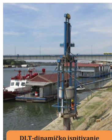
DLT-dinamičko ispitivanje šipova
