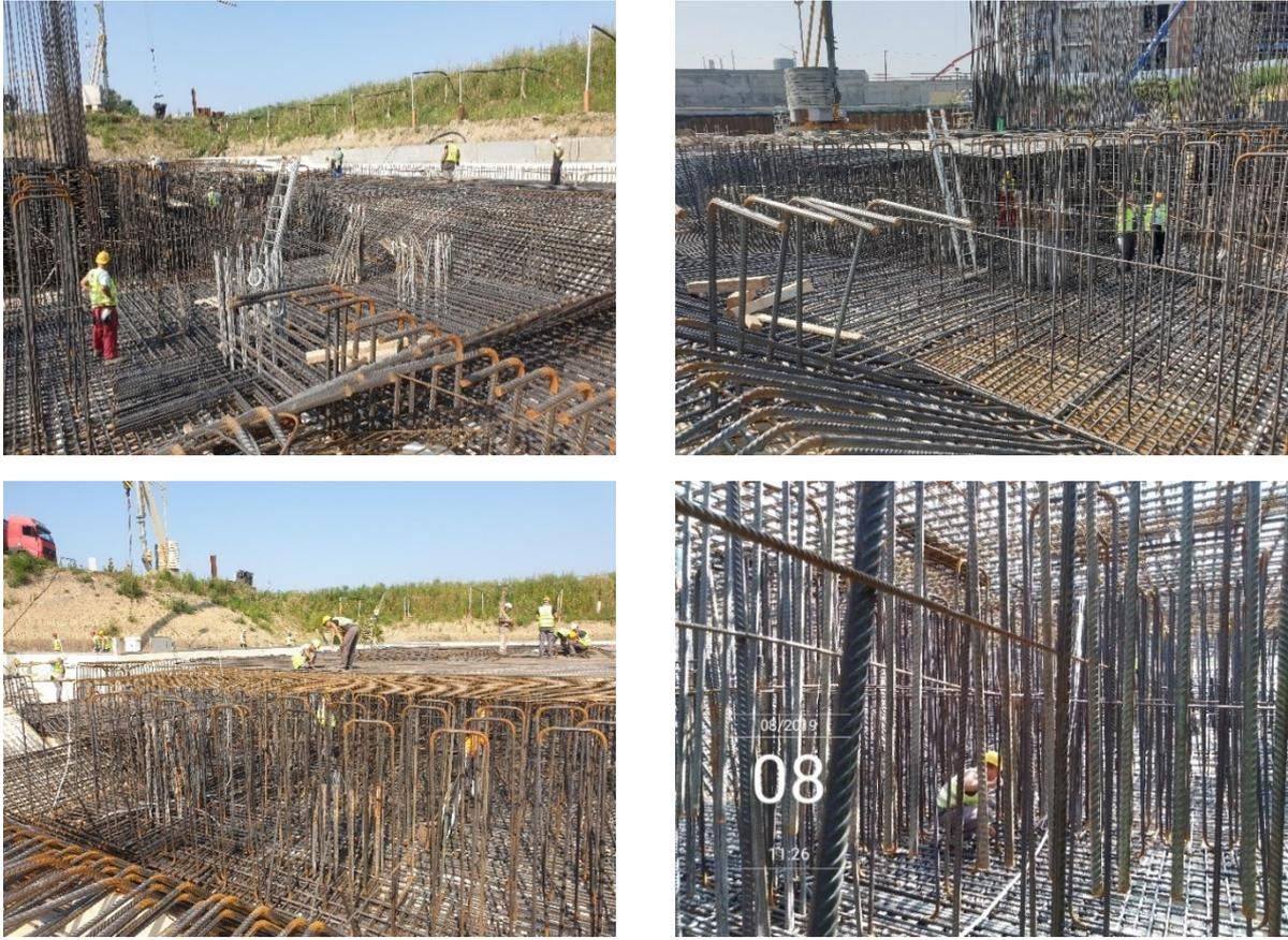
Figure 10. Reinforcement works on pour 1.2 – raft pour under the tower
