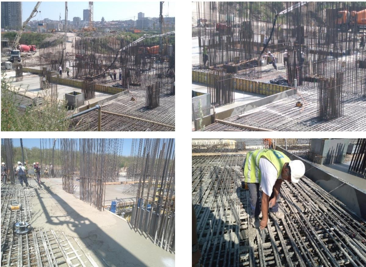
Figure 11. Casting of raft pour 1.2 under the tower
